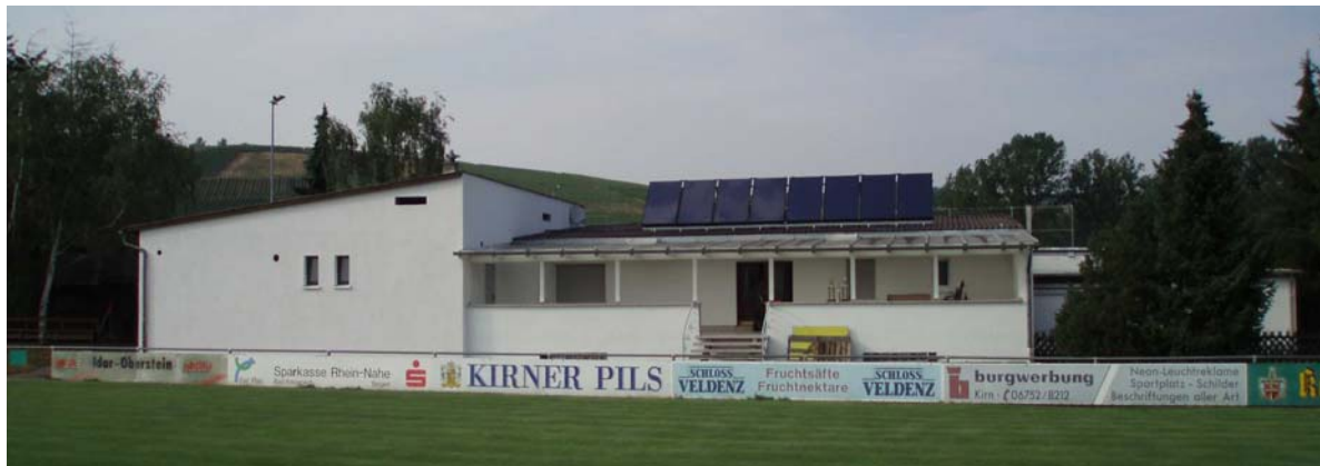
Vereinsheim mit aufgeständerter Solaranlage
