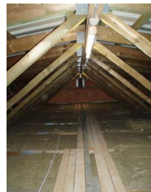
Dämmung des Daches
