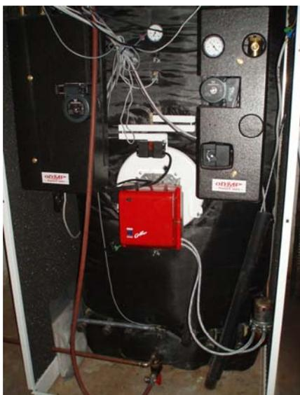
**Warmwasserspeicher mit integriertem Ölbrenner**
