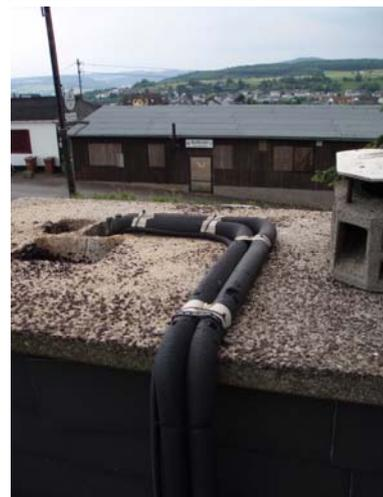
**Nutzung des bestehenden Kamins zur Installation der Leitungen der Solaranlage**
