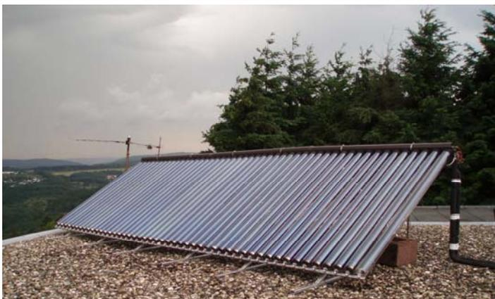
**aufgeständerte solarthermische Röhrenkollektoranlage**
