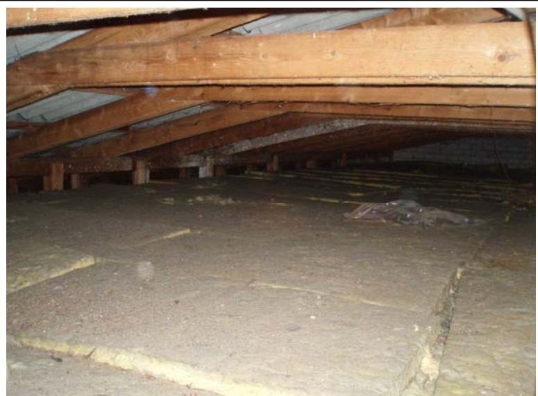
Dämmung des Dachbodens
