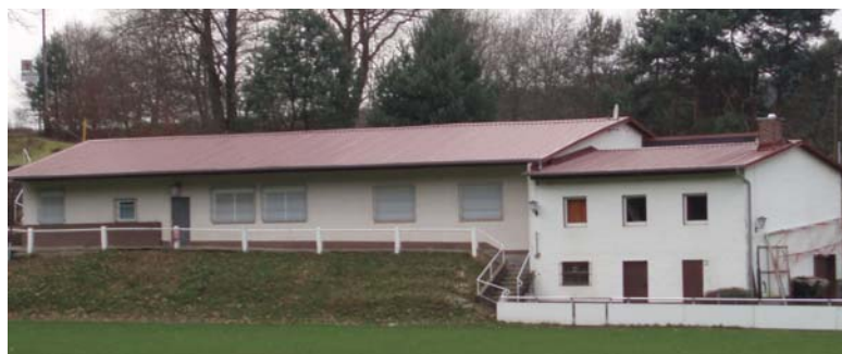
Außenansicht des Gebäudes mit neuer Dachhaut
