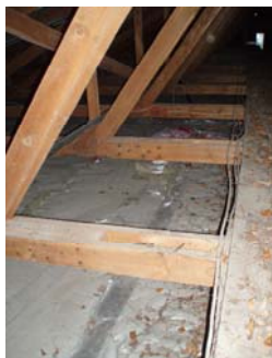
Dämmung des Daches
