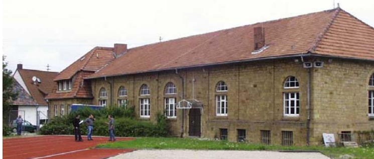
Außenansicht der Turnhalle
